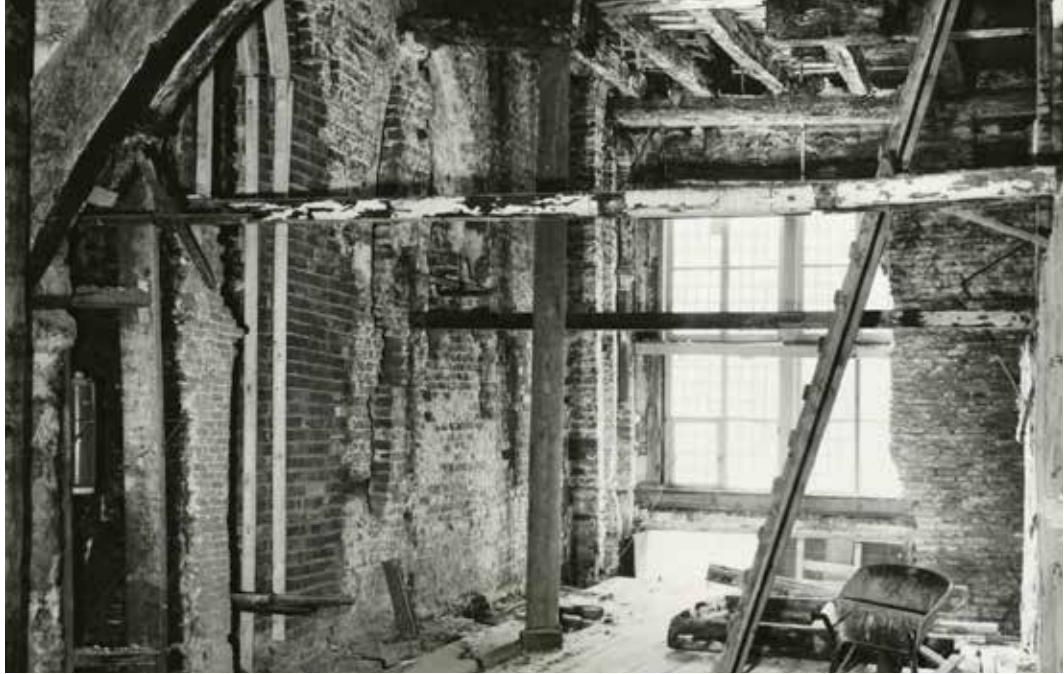
De Moriaan tijdens restauratiewerkzaamheden, 1962
